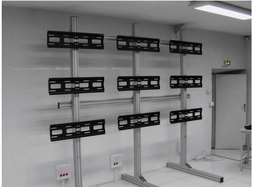
Exemple structure autoporteuse 9 écrans
