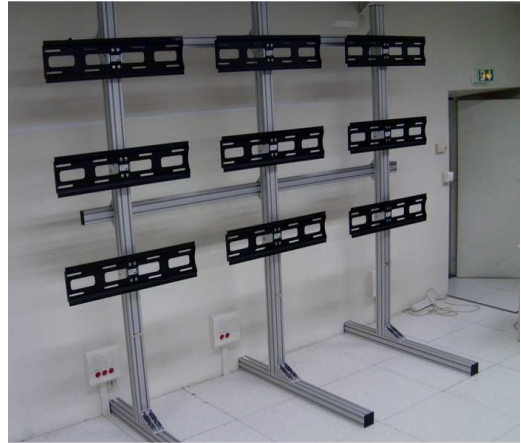
Structure Autoporteuse (posée)
